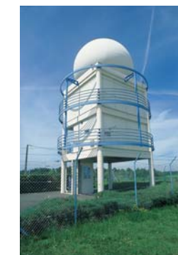
Station Météo France de Damblainville
